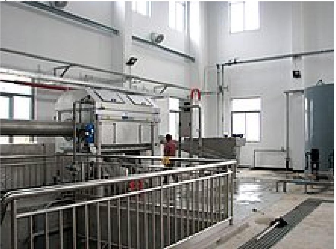
Bild 4: Feinstsiegung mit einer RoMesh® Siebtrommel
