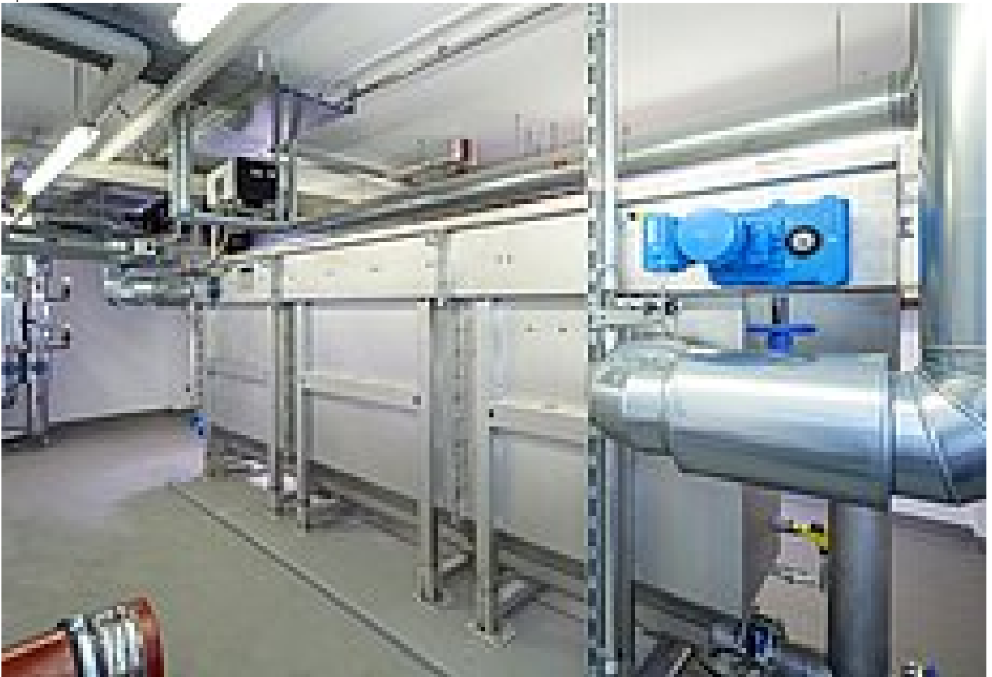
Geflanschte Version des HUBER Wärmetauschers RoWin - perfekt eingebracht und installiert auch bei beengten Platzverhältnissen
