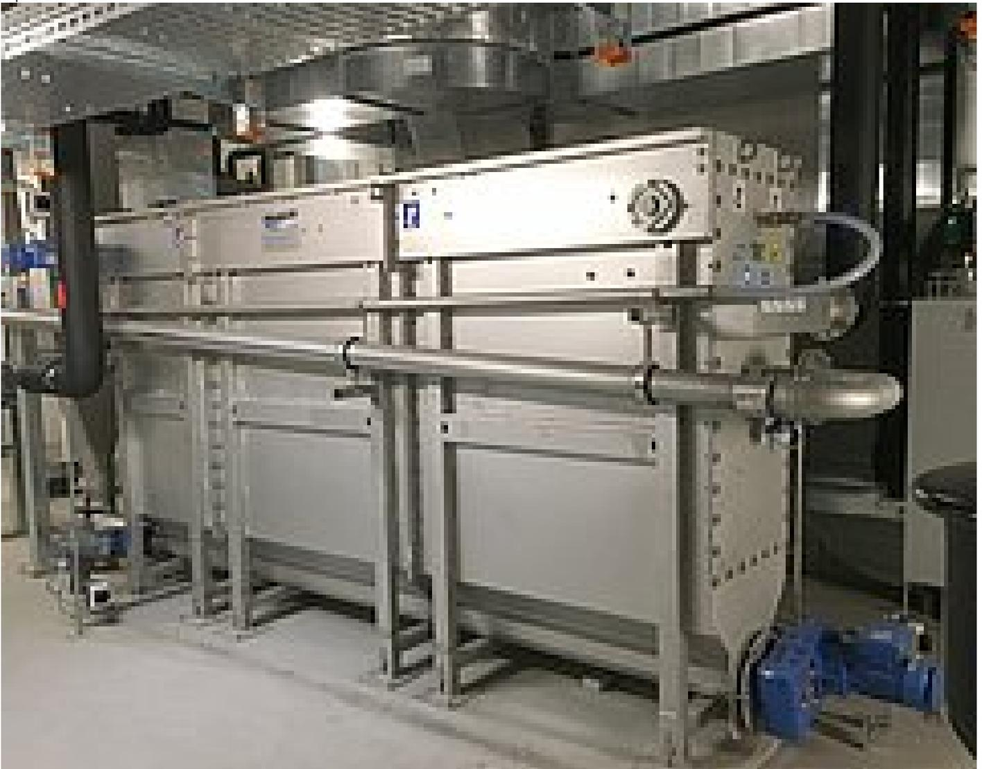
Abbildung 3: HUBER Wärmetauscher RoWin im Technikraum des Valsana
