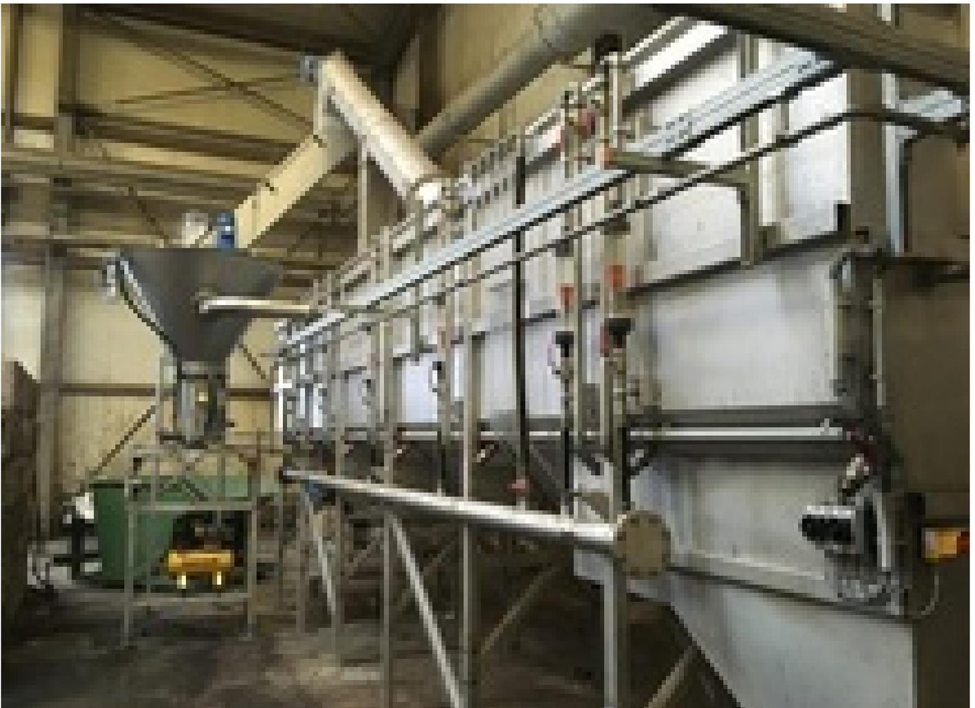
Bild 1: HUBER Langsandfang ROTAMAT® Ro6 Bio (rechts) mit nachfolgender HUBER Sandwaschanlage RoSF G4E (links)
