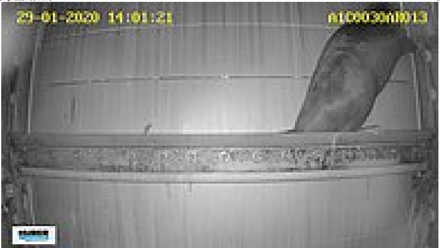
HUBER Störstofferkennung Safety Vision erkennt Biber in HUBER Harken-Umlaufrechen RakeMax® und rettet ihm das Leben
