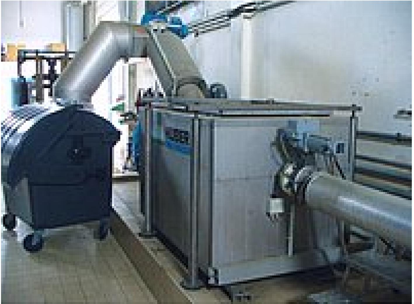
*Zusätzliche Energie bei der Faulung durch modifizierte Fäkalannahmestation zur Fettannahme und Abtrennung von groben Inhaltsstoffen*
