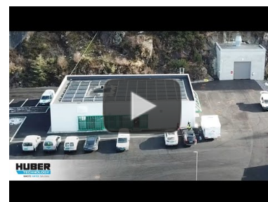
Video: Komplette Abwasserbehandlung auf der Kläranlage Øygarden in Norwegen https://www.youtube.com/watch?v=fcd8KDhYoL8
