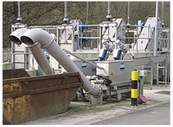
Rechengutwaschpresse mit erhöhter Entwässerungsleistung für Schwemmrinnenbeschickung
